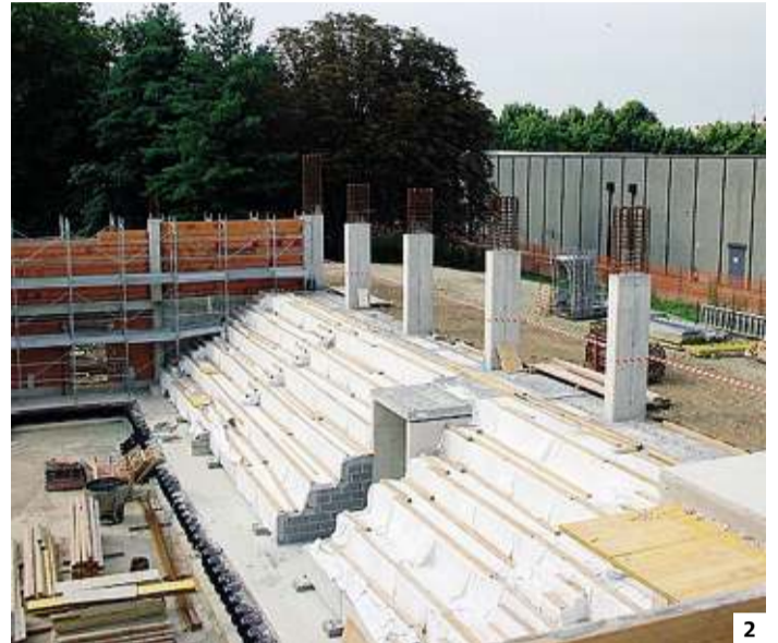
Due immagini del cantiere: il palazzetto avrà tribune con 600 posti a sedere, due palestre, spazi per disabili. Al secondo piano troverà posto il bar-ristorante Foto Gianni Radaelli
